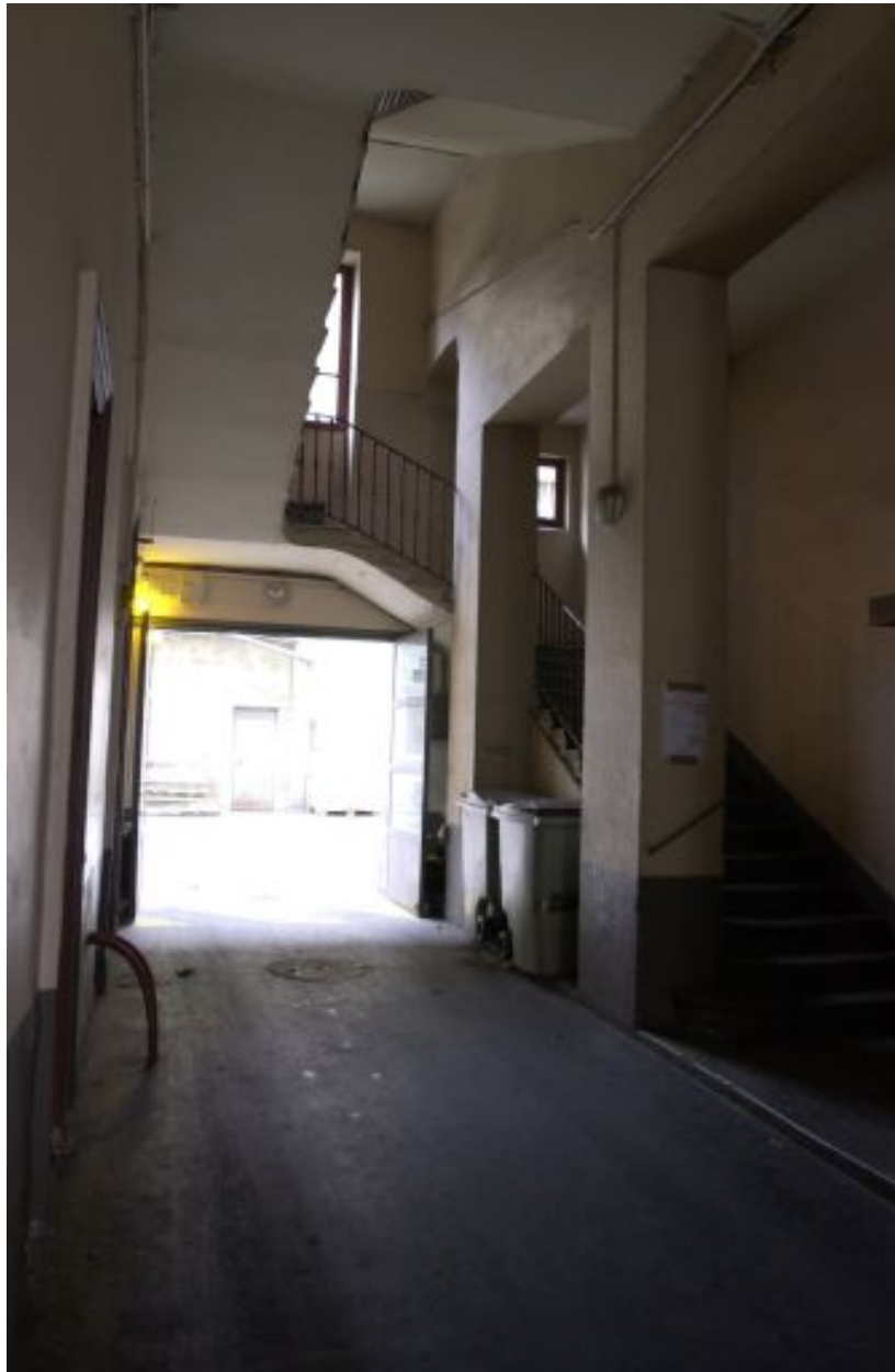
Vue du passage couvert depuis la rue et départ de la montée d'escalier
