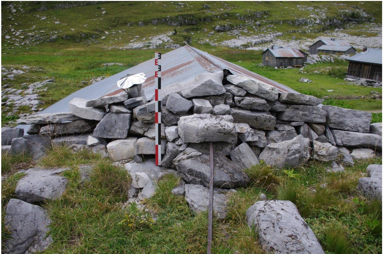
Vue de la toiture de puis la terrasse supérieure
