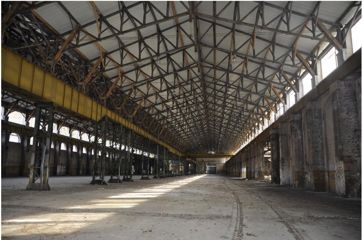
Vue d'ensemble du grand système de charpente
