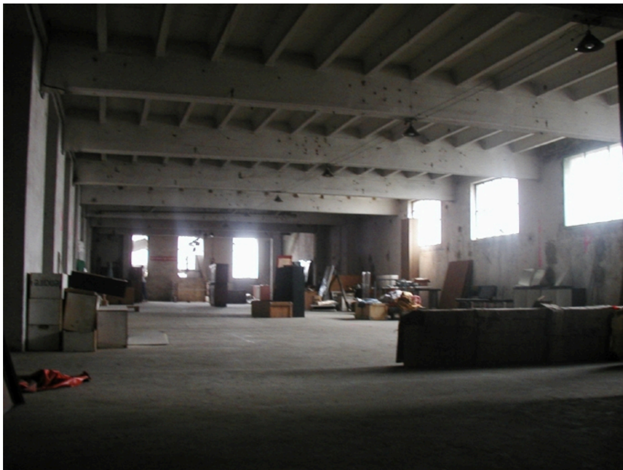
Vue d'ensemble du premier niveau
