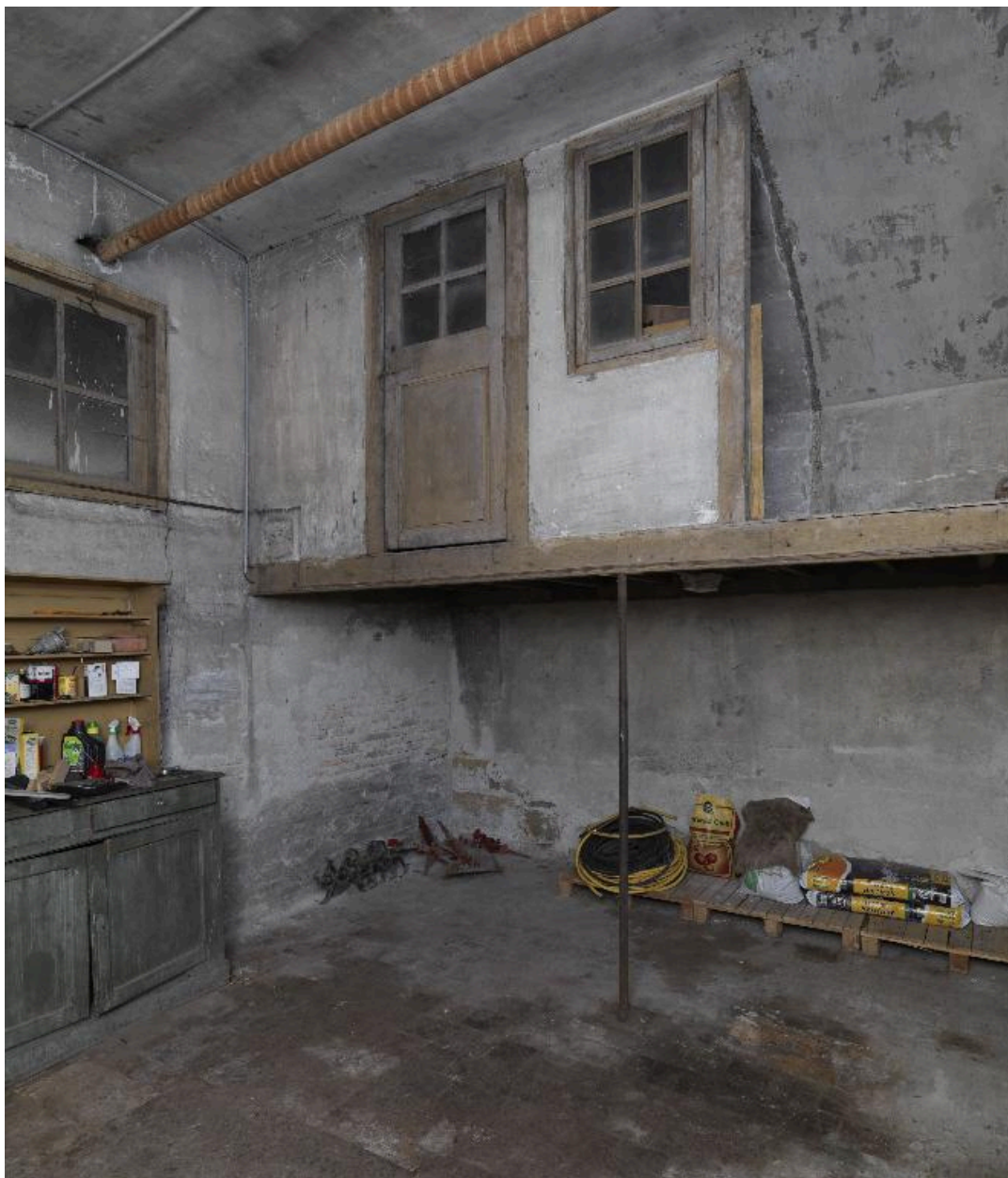
Pavillon sud-ouest, étage de soubassement : ancienne boulangerie, vue d'ensemble depuis l'ouest
