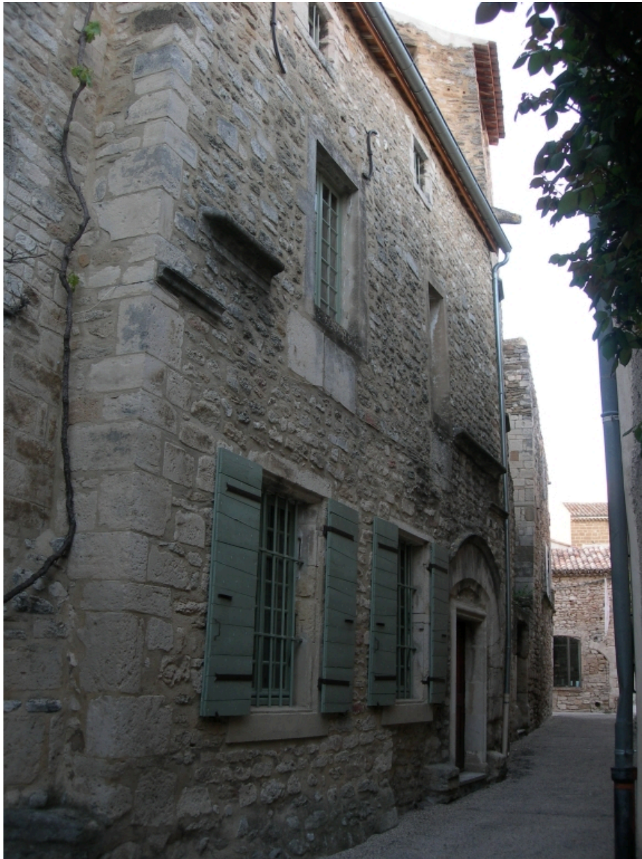
Façade sur rue, vue partielle, prise depuis le sud.
