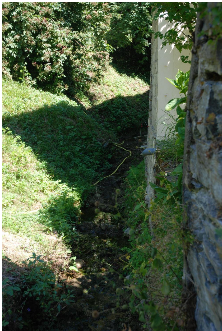
Passage du ruisseau sous 2018 H2 620.
