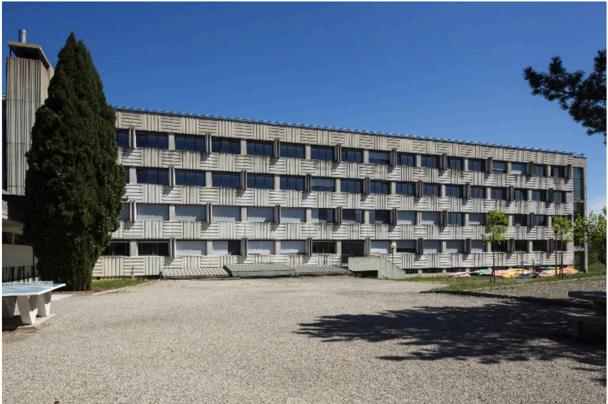
Bâtiment sud : façade ouest
