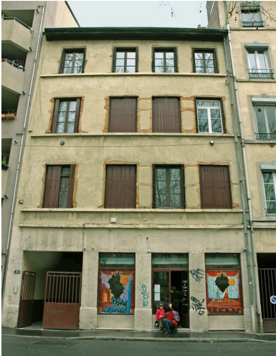
Façade la rue Claude-Boyer vue depuis l'ouest
