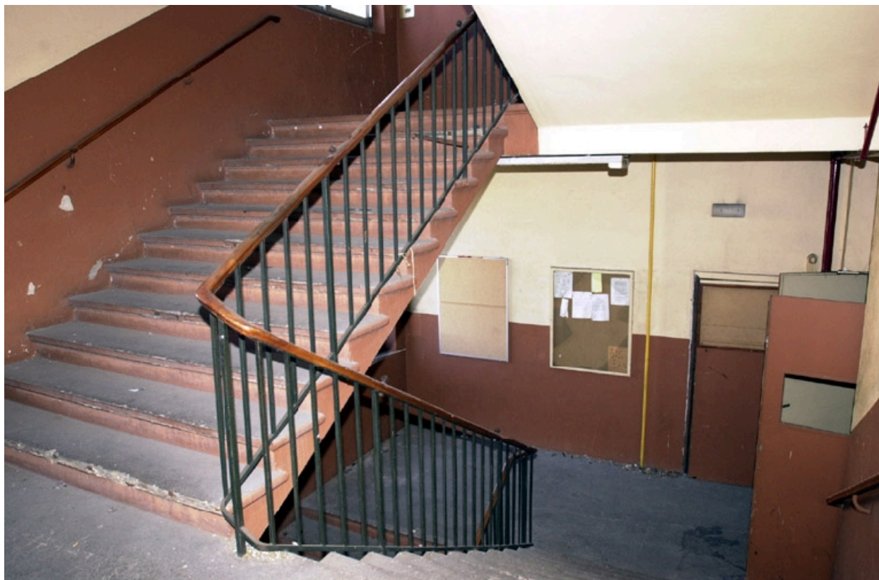
Vue de l'escalier
