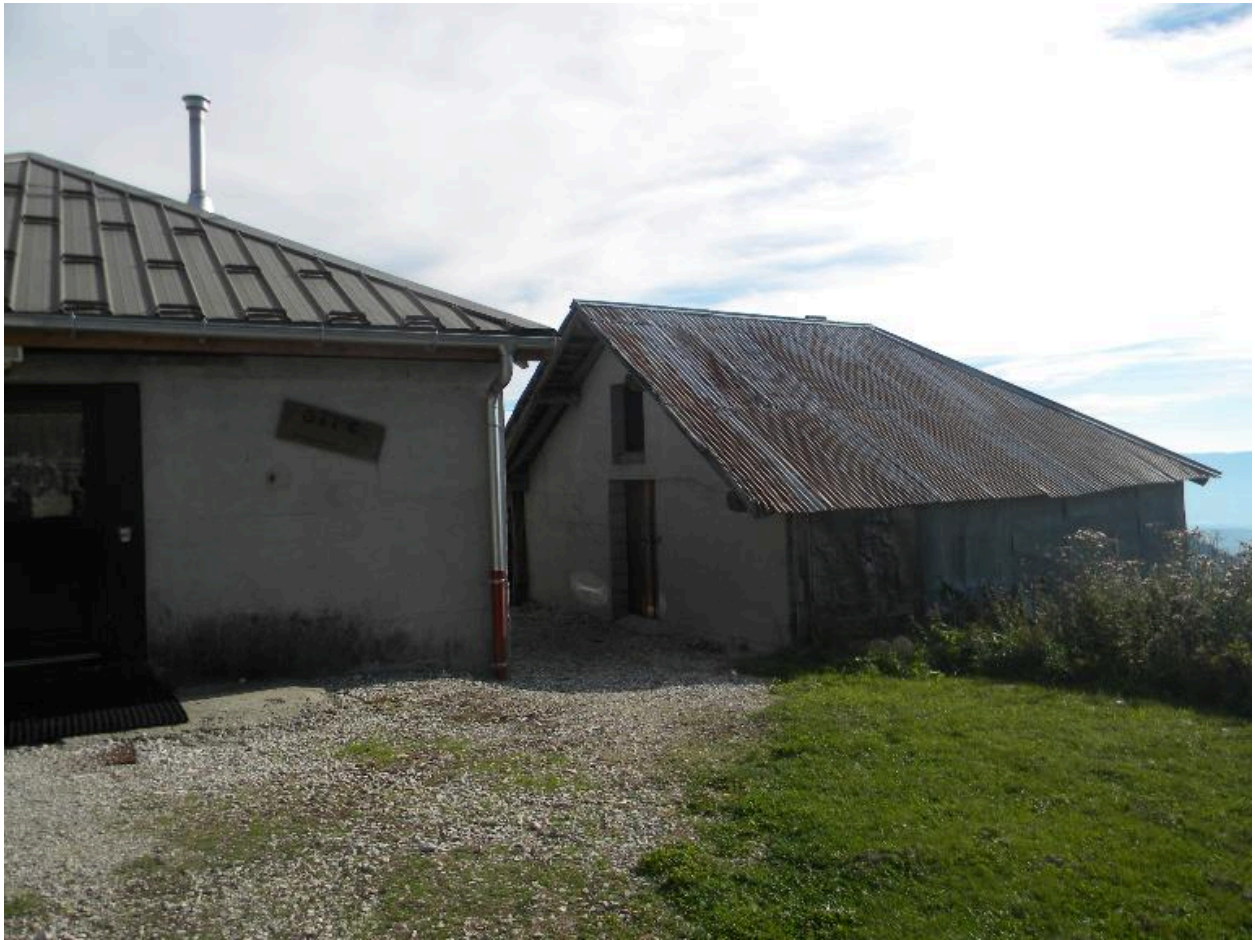
Vue d'u bâtiment de l'ancienne étable à côté du dortoir.
