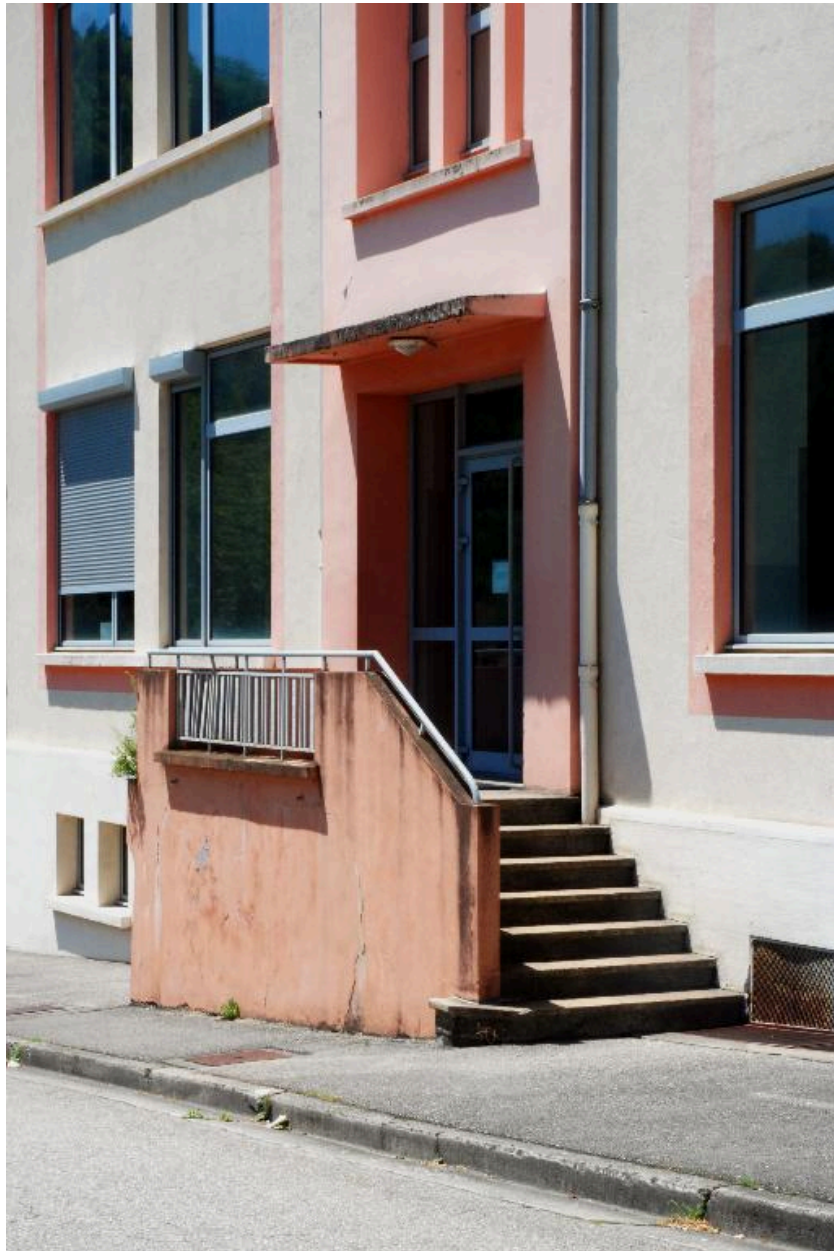
Elévation latérale est : détail de l'escalier
