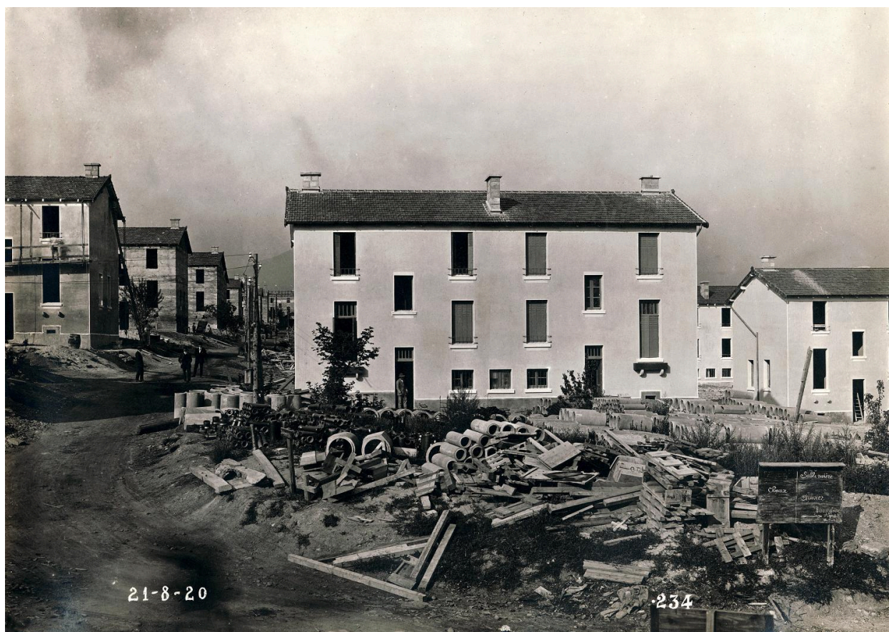
Chantier de construction de la cité, 21 août 1920.
