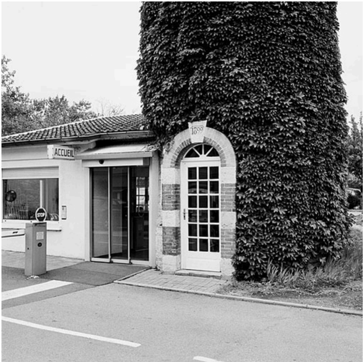
Cheminée ou éolienne avec date portée
