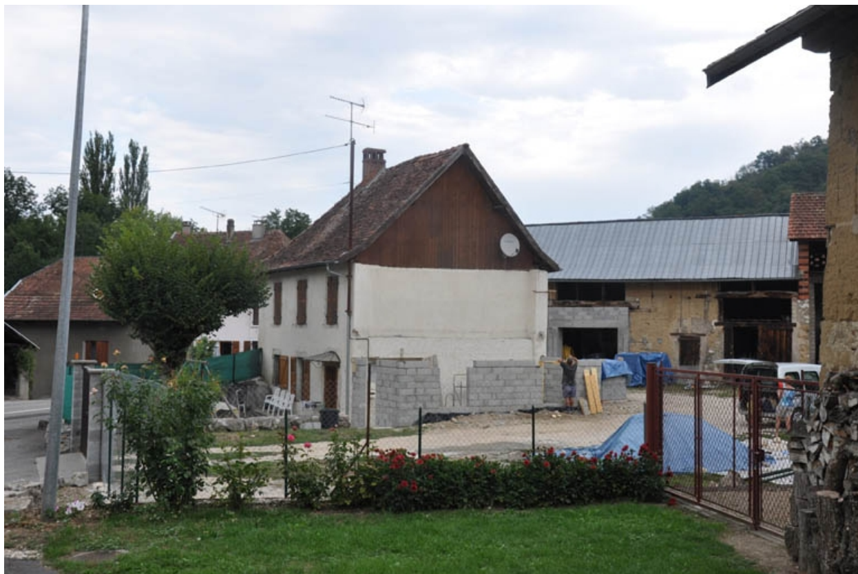
Vue générale de l'ancienne scierie, vue du logement façades sud et est
