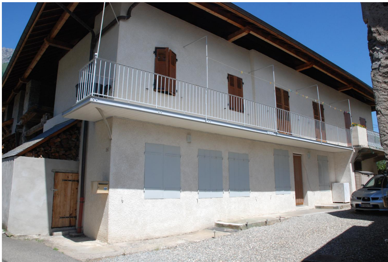
Rue de la Rampe, ferme (2018 H2 555).
