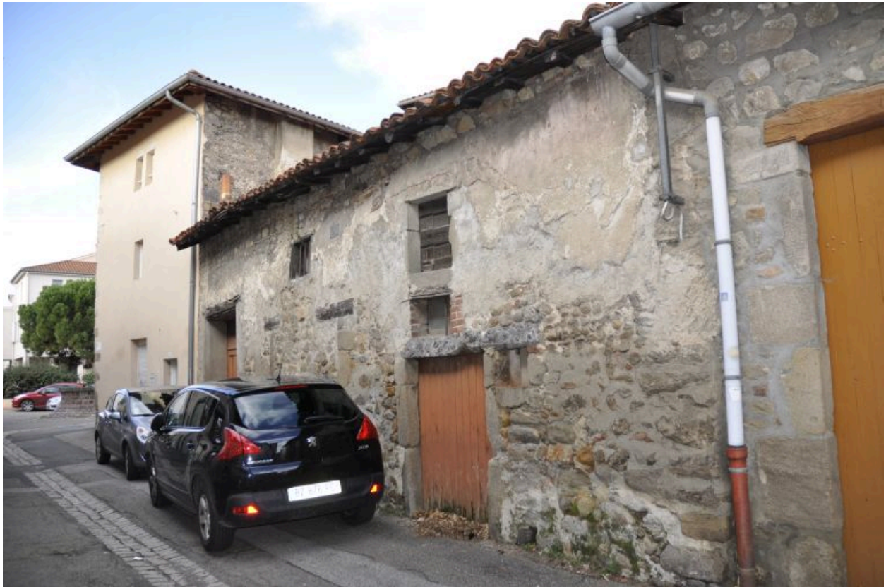
1986 AE 100, 101, 102. 20 rue Centrale. Cuvages, vue d'ensemble des élévations sur rue.
