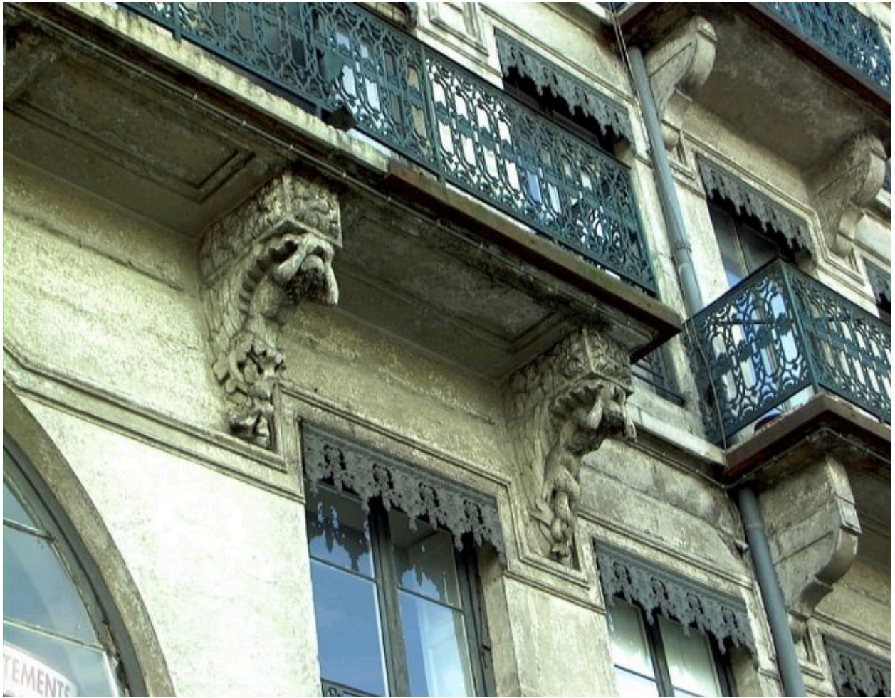
Détail du balcon et de ses supports, à droite
