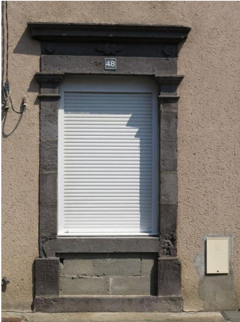
Fenêtre (ancienne porte ?) avec frise ornée
