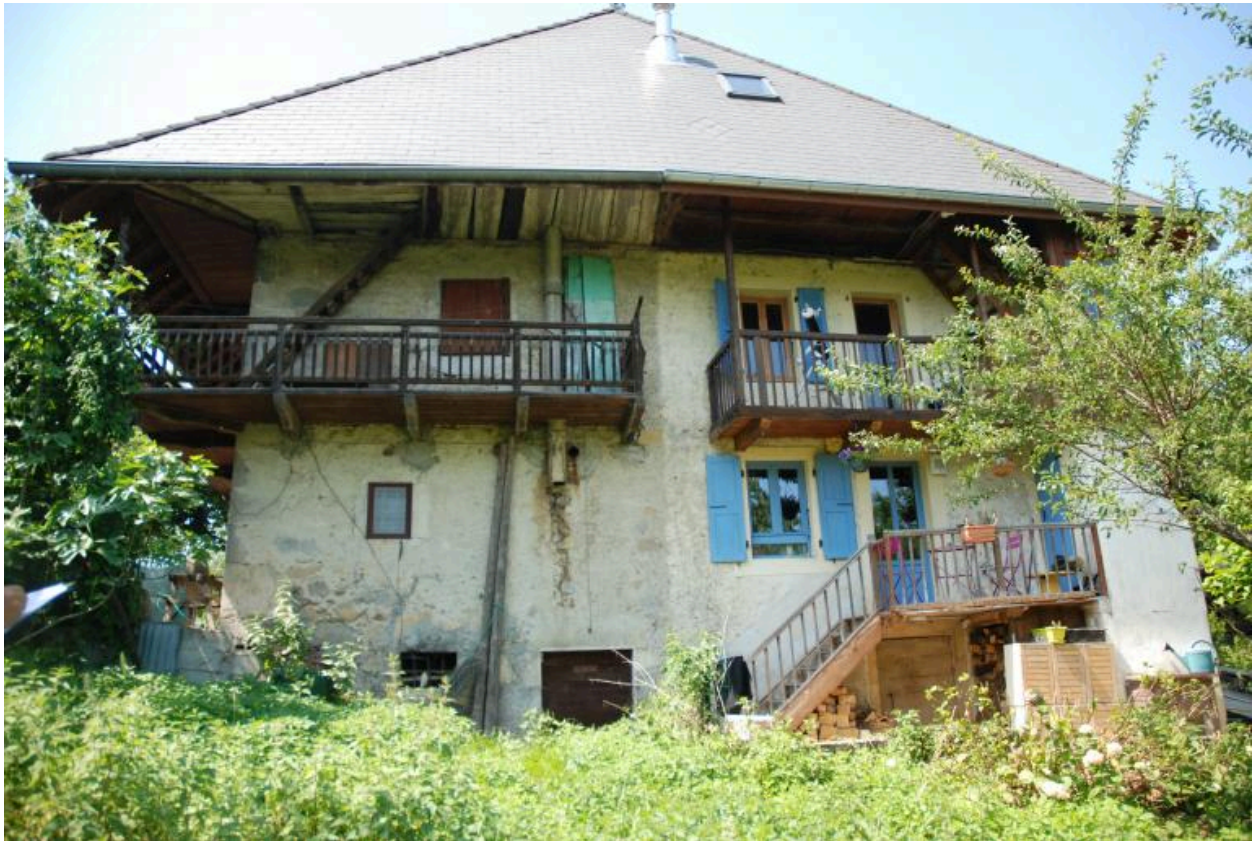
Ferme (2016 A6 1080 à 1083, 1114, 1115, 1131 à 1134, 1656 à 1659, non repérée). Mur pignon.
