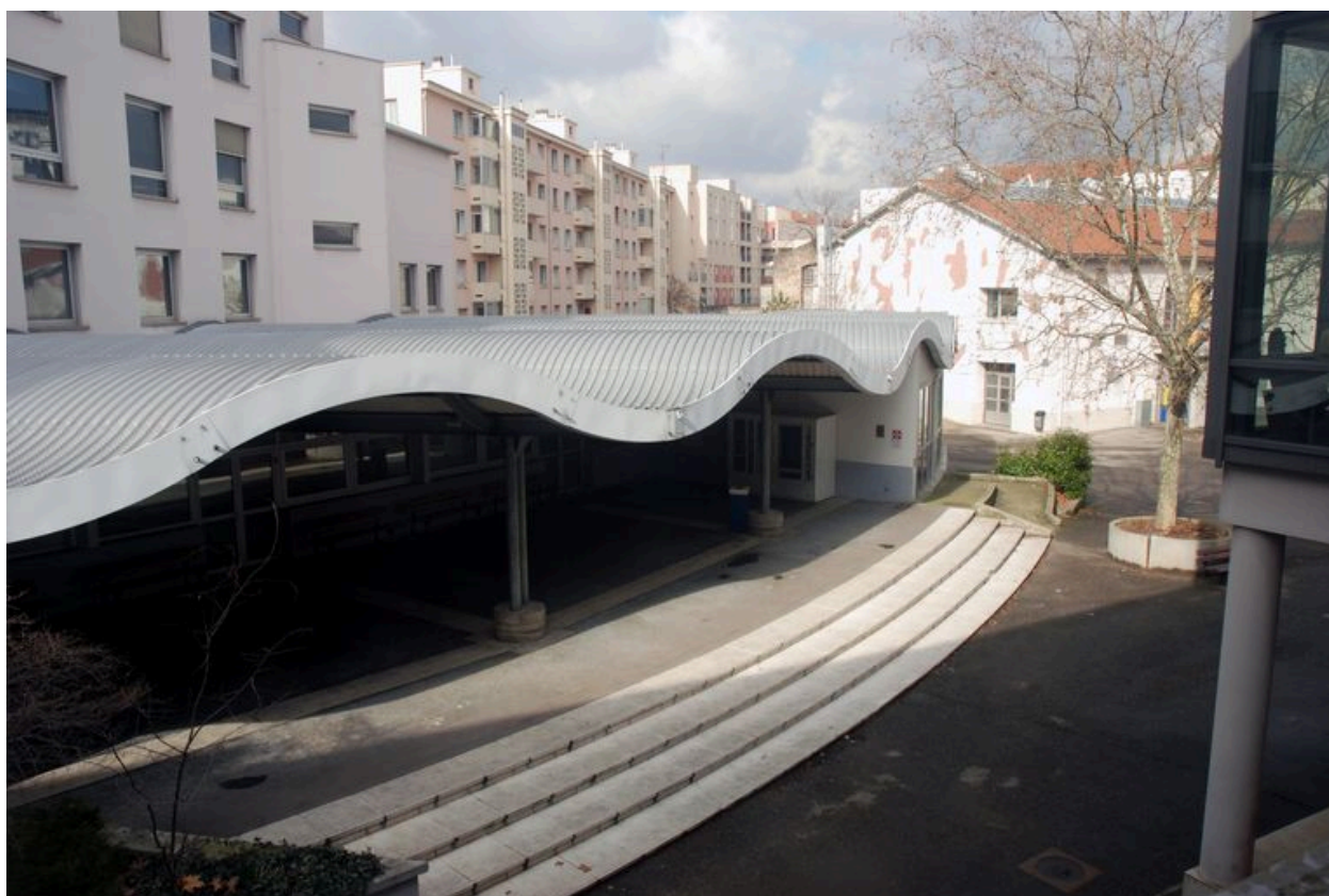
Bâtiment A : vue du préau
