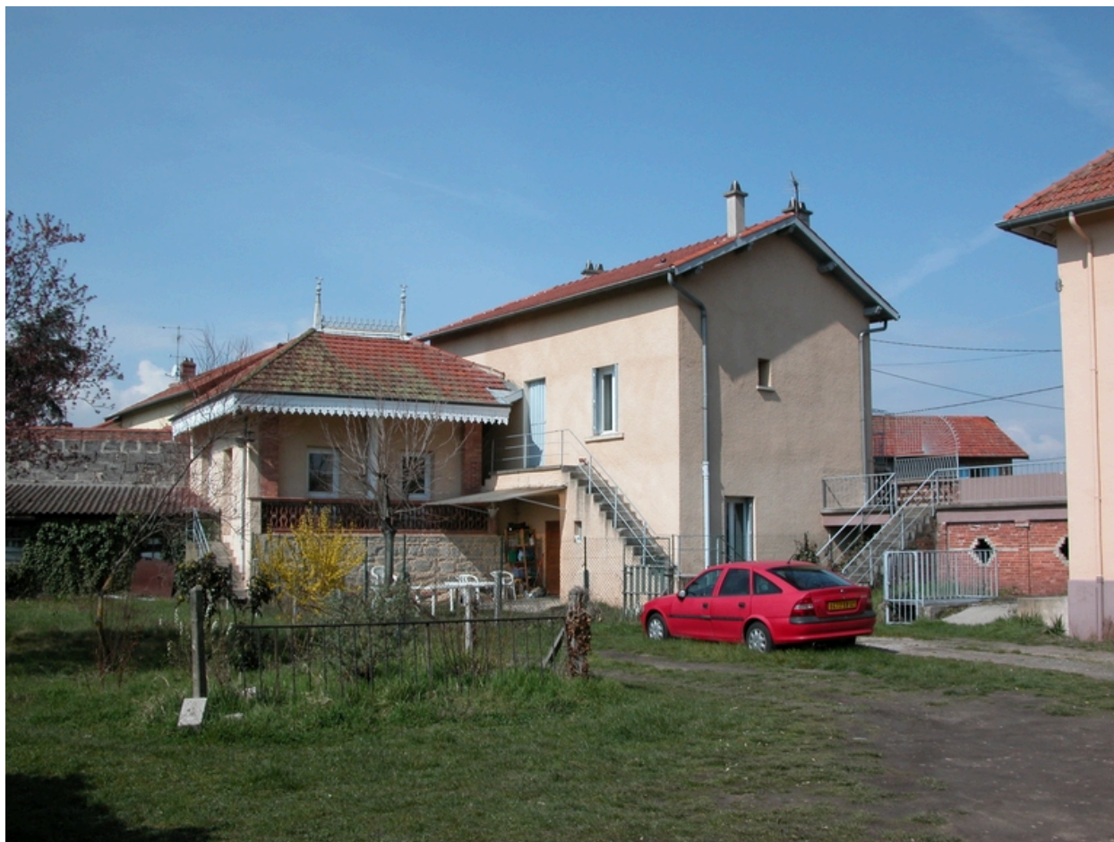
Ancien presbytère et hangar (église provisoire ; 1997 BA 160). Vue arrière.
