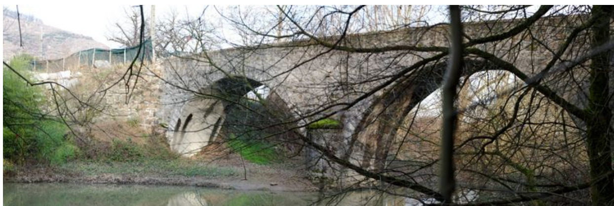
Vue panoramique, face aval (depuis la rive gauche)
