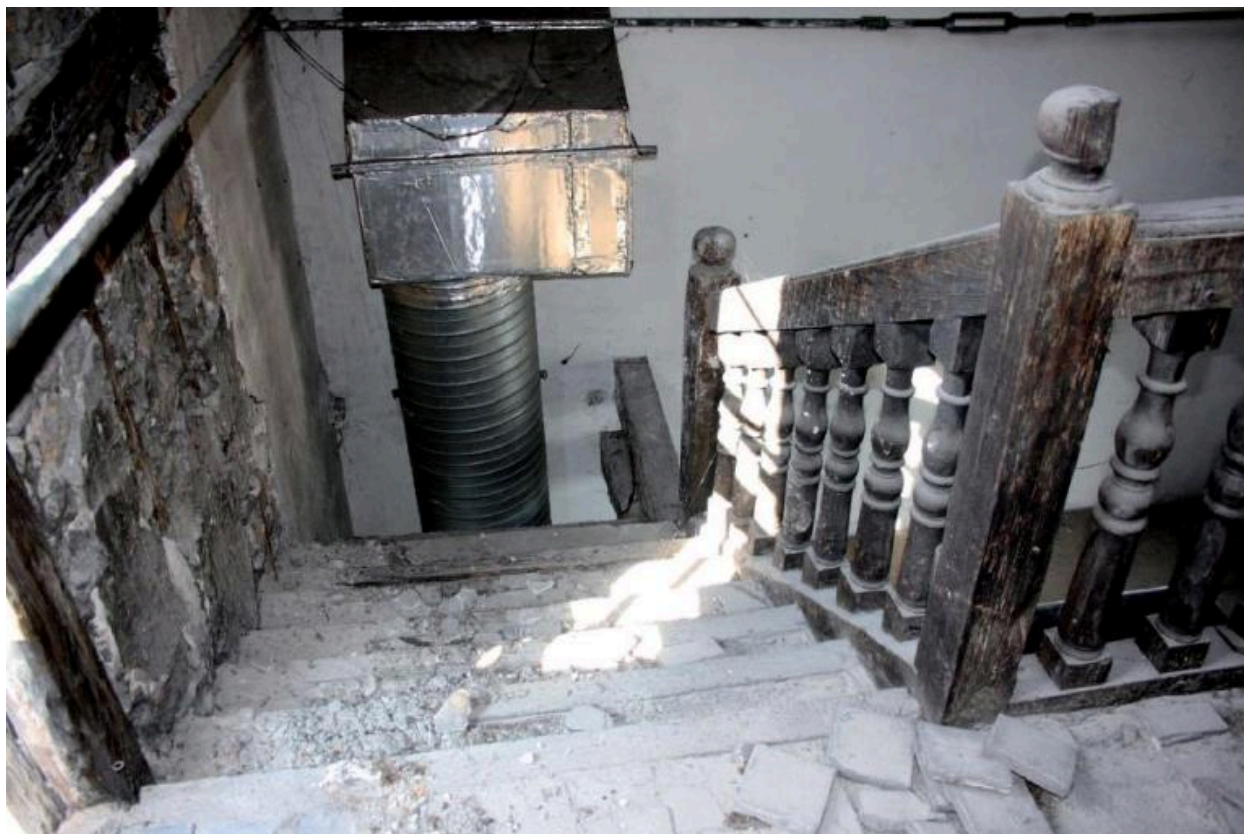
Escalier d'accès au magasin des in-folio, état actuel (photogr. SAVL)
