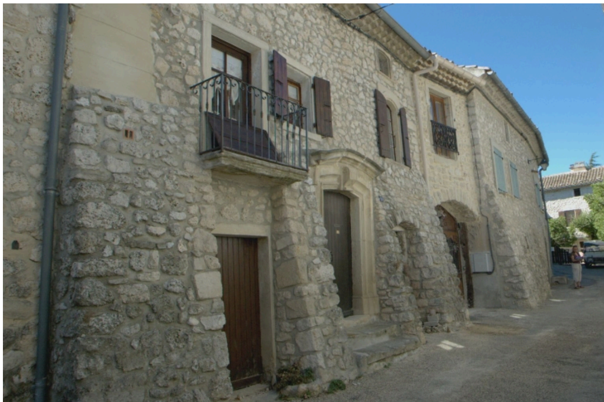
Maisons, 24 et 26 Grande rue. Façades talutées sur la hauteur du 1er niveau.
