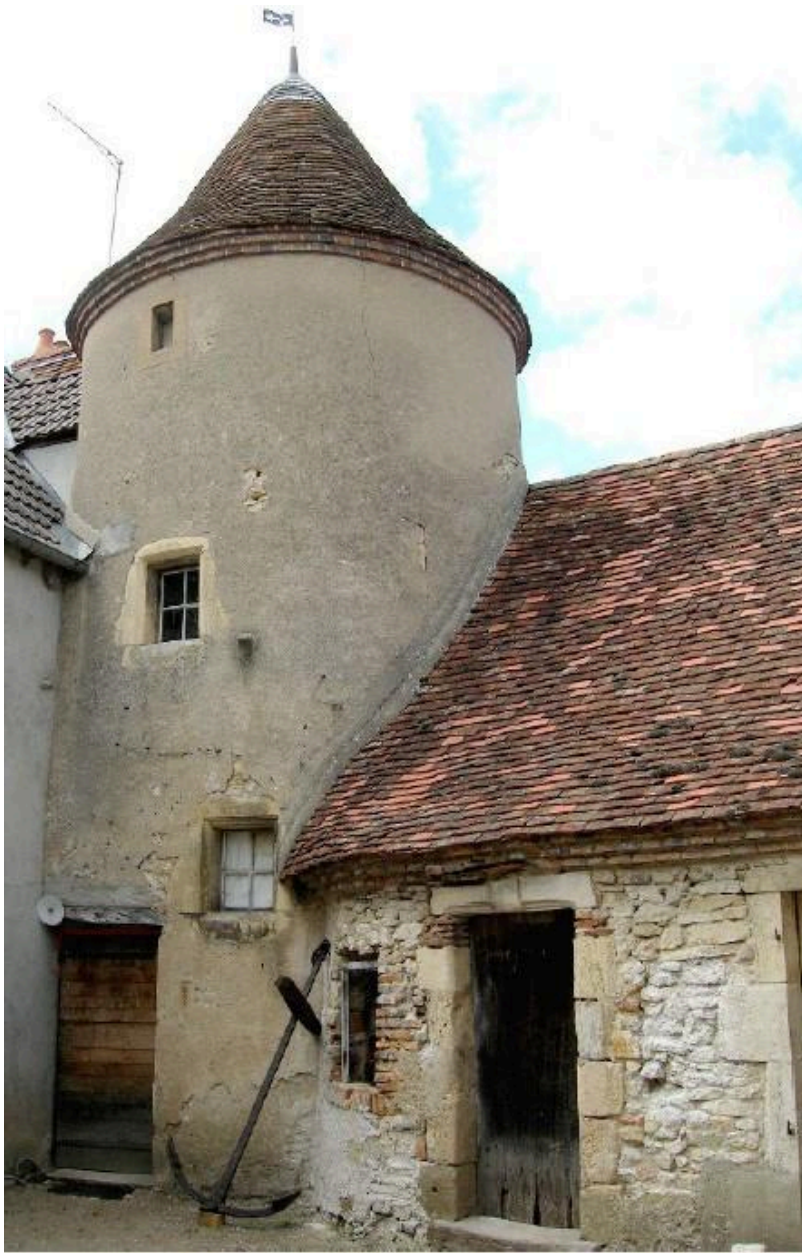
Façade méridionale du bâtiment sur cour avant restauration
