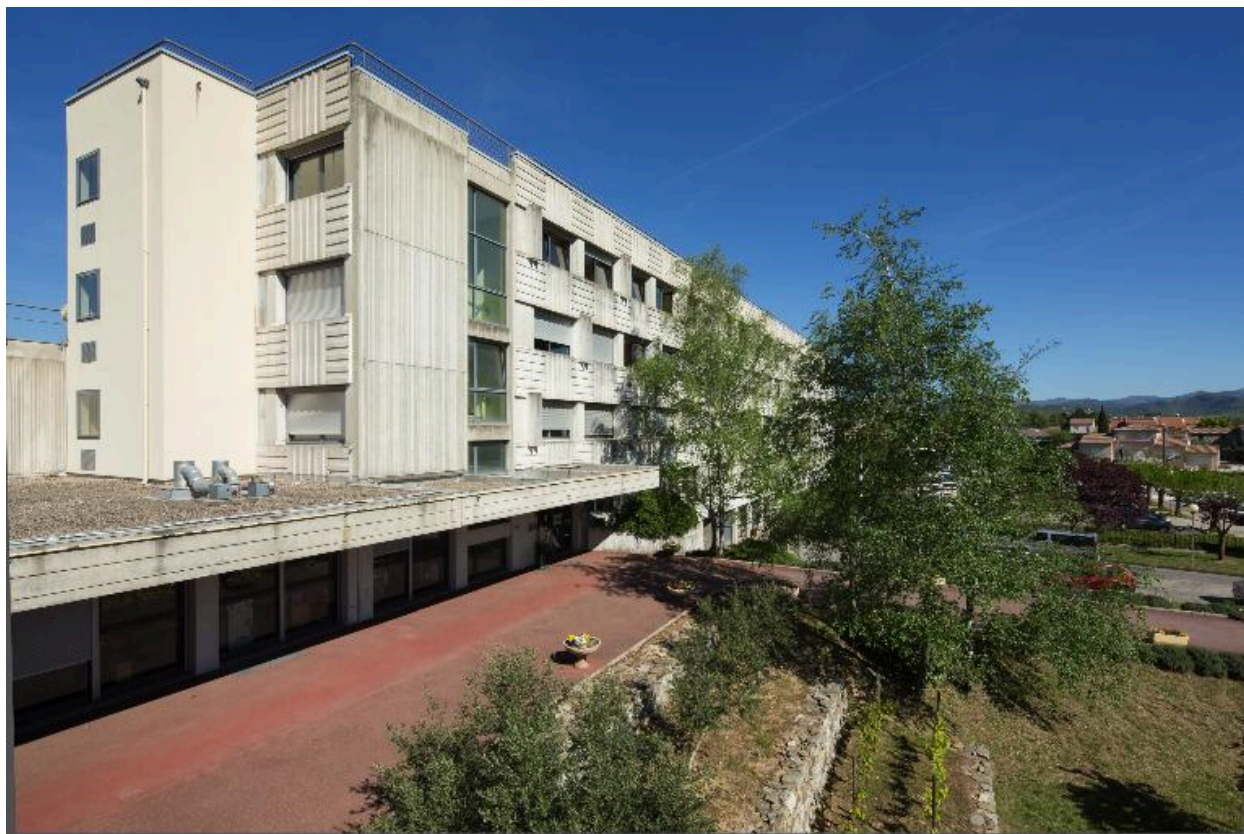
Bâtiment nord : entrée administrative et façade est.
