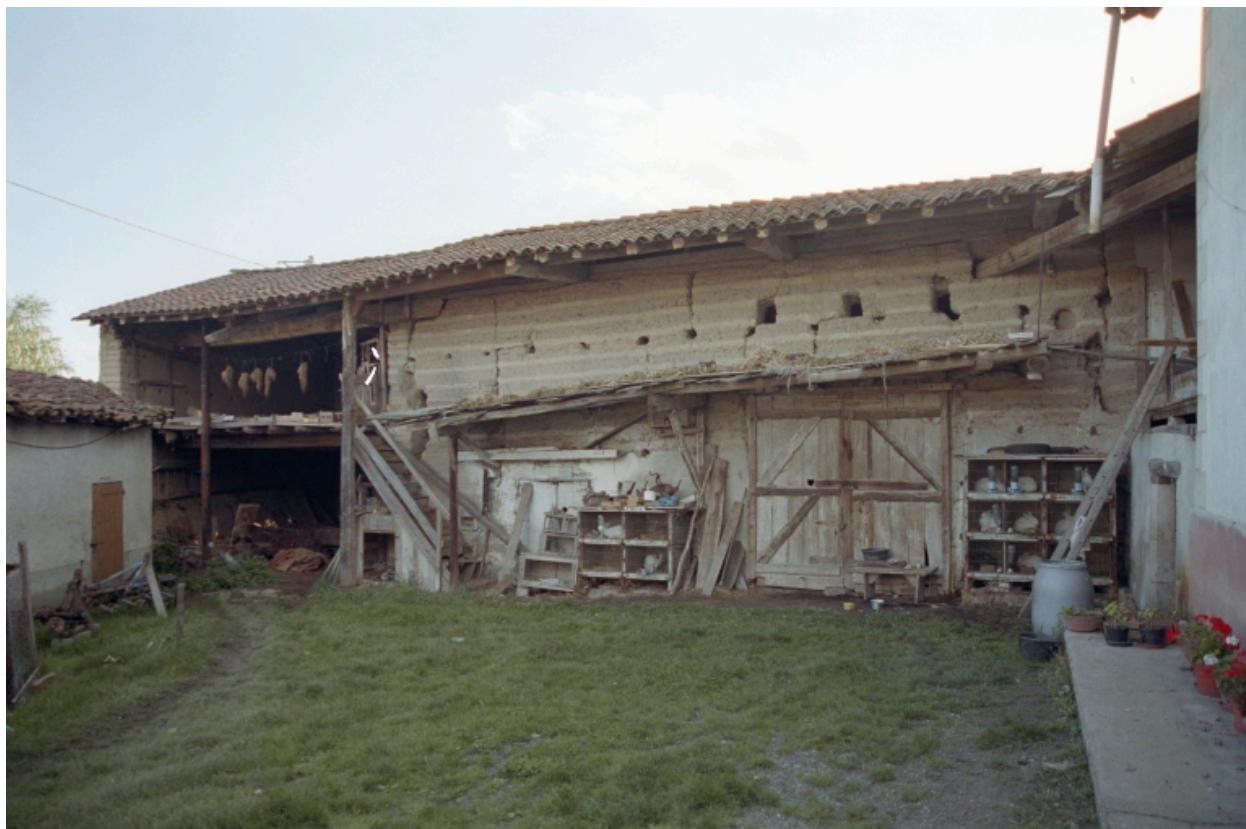
Vue d'ensemble de la grange-étable.
