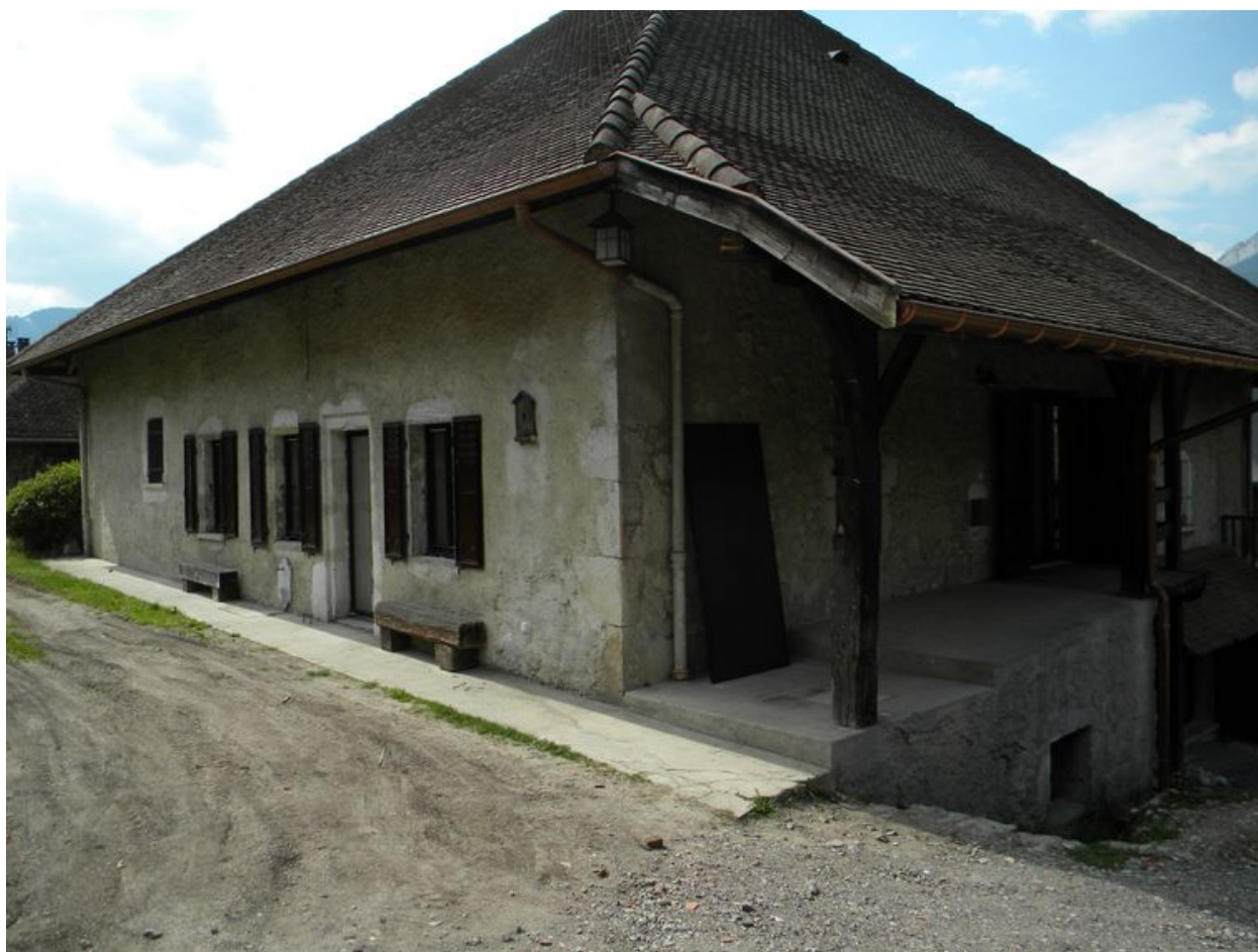
Façades est et nord, vue de trois-quarts.
