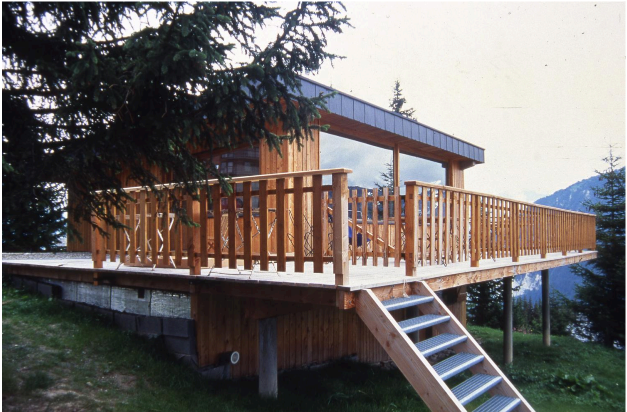
Vue de l'escalier d'accès à la coursière depuis le sud-ouest
