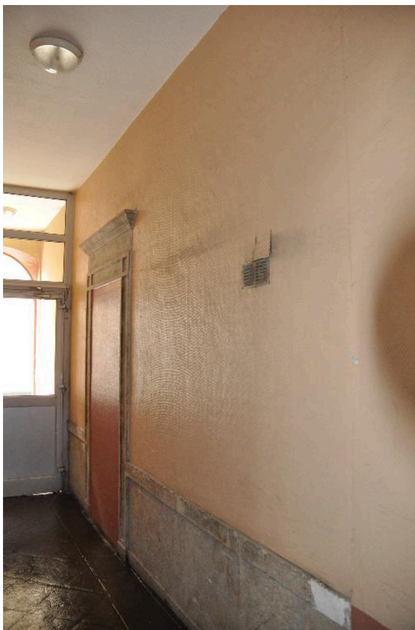
Vue de l'allée depuis l'escalier
