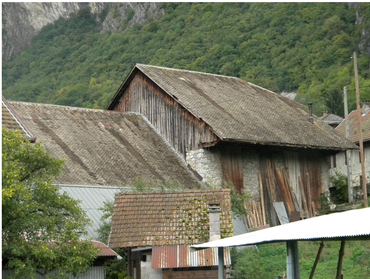
Vue des façades arrières.
