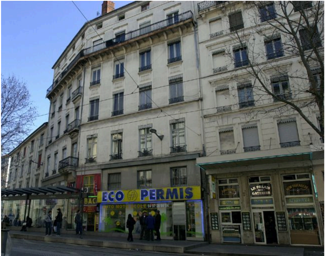
Vue générale depuis le sud
