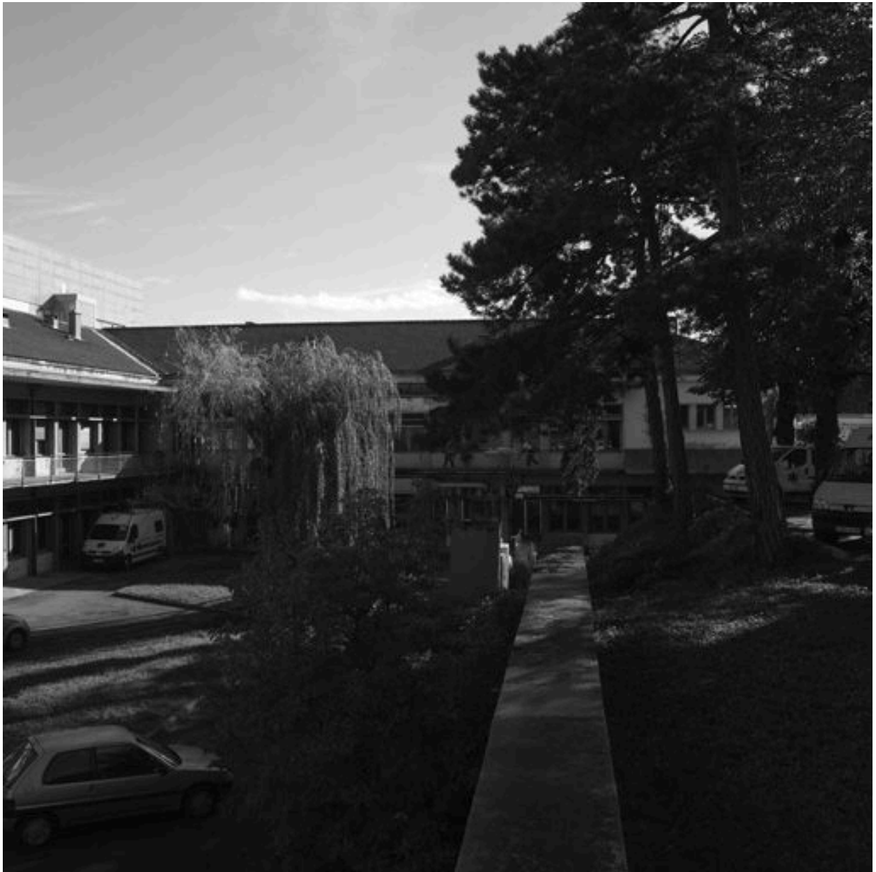
Bâtiment W, vue générale sur la cour ouest
