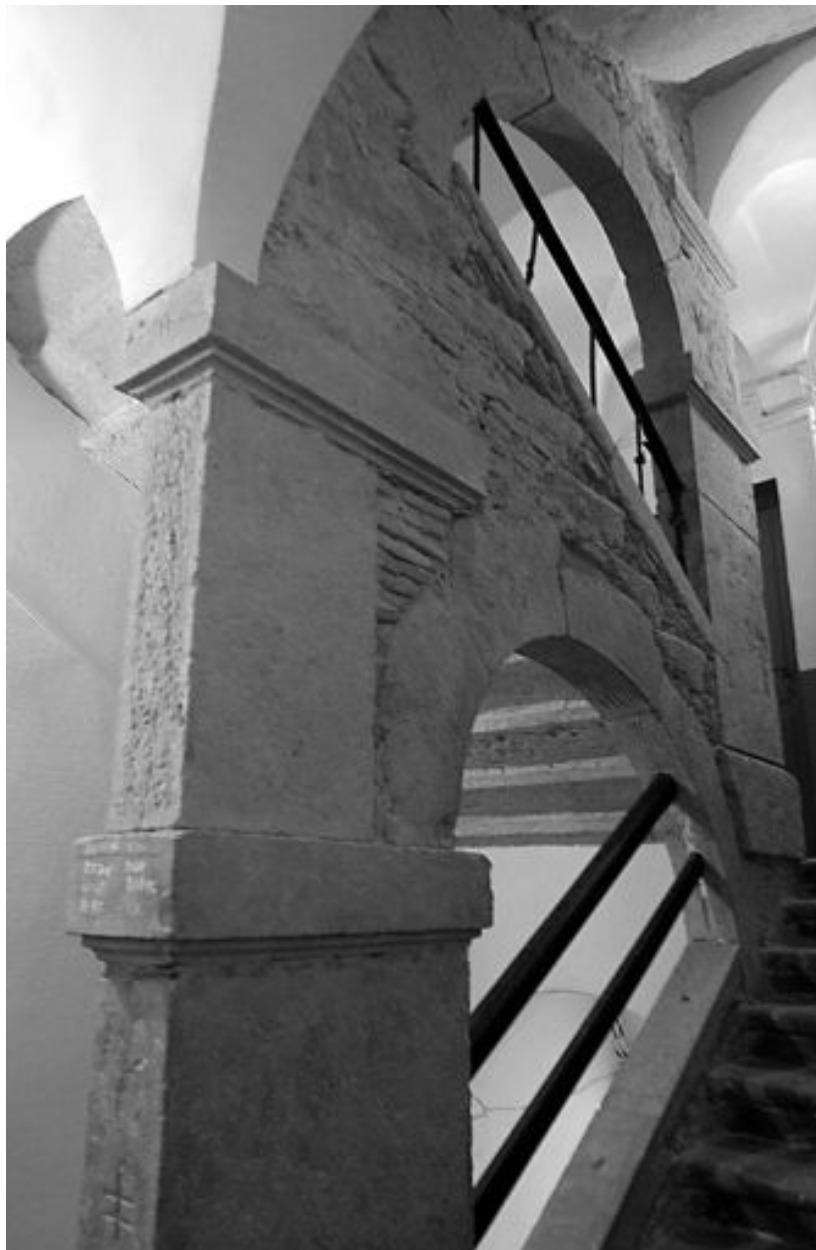
Escalier, mur noyau vue depuis le 1er repos en direction du palier du 1er étage
