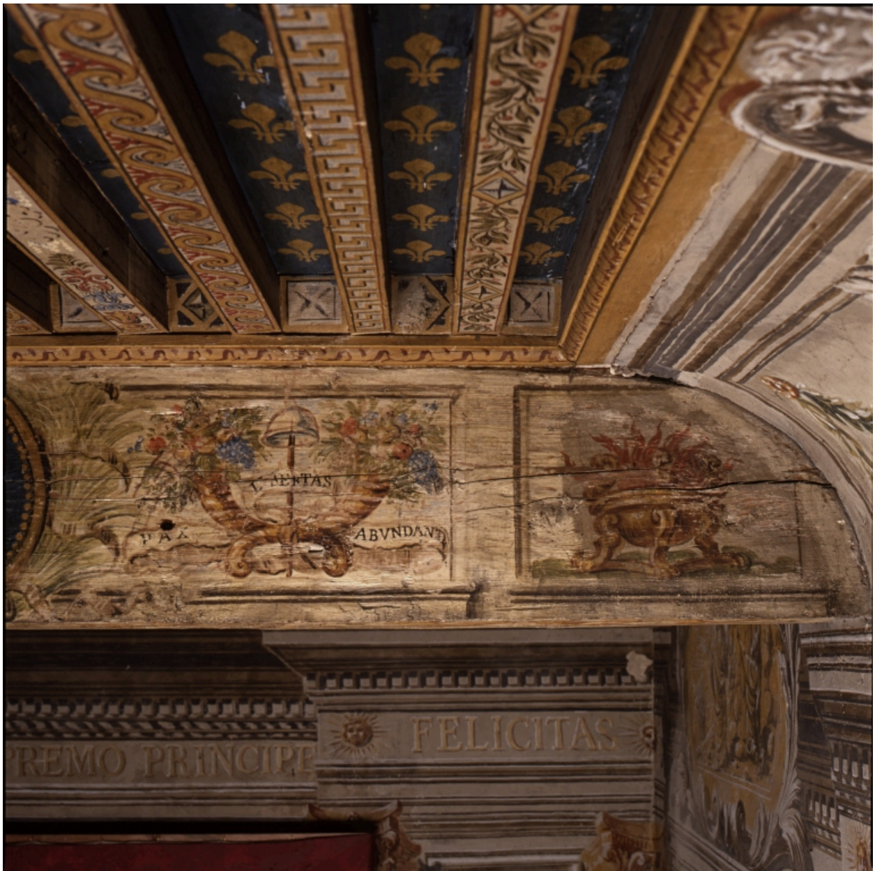
Poutre 5, face nord, extrémité droite : bonnet d'affranchi et cornes d'abondance.
