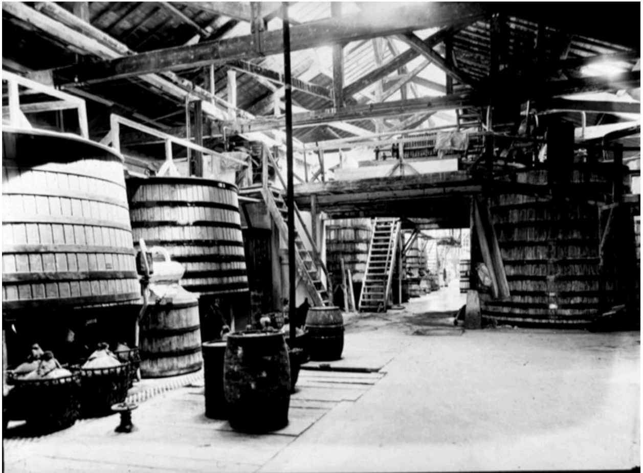
Vue des cuves de stockage des grandes caves de Lyon, BM Lyon-vidéralp collection Sylvestre 1930
