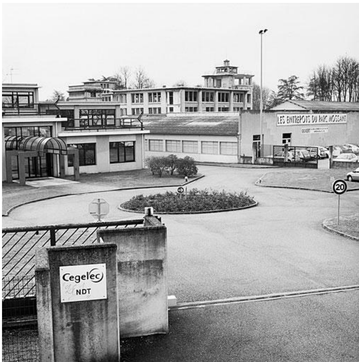
Vue d'ensemble est
