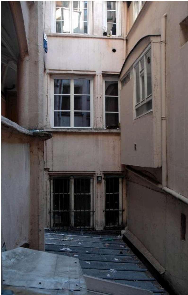
Elévation du corps de bâtiment sur cour (1er, 2e et 3e étages) vue depuis la 2e fenêtre de la cage d'escalier.
