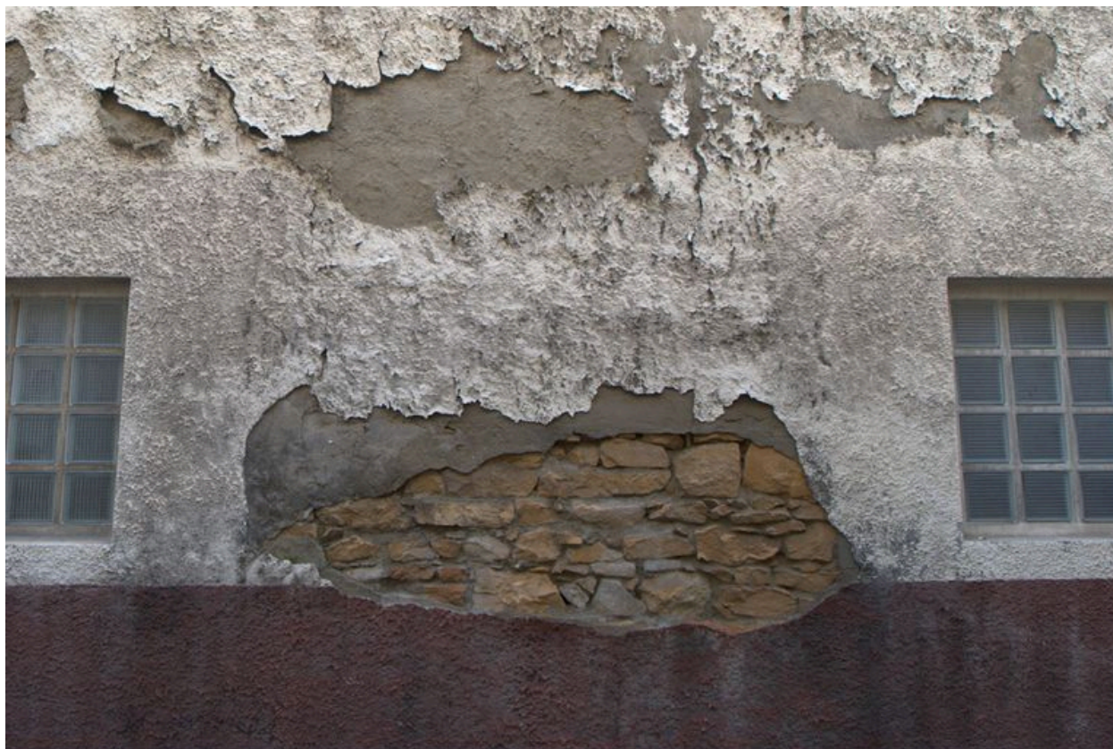
Détail du mur de l'élévation latérale
