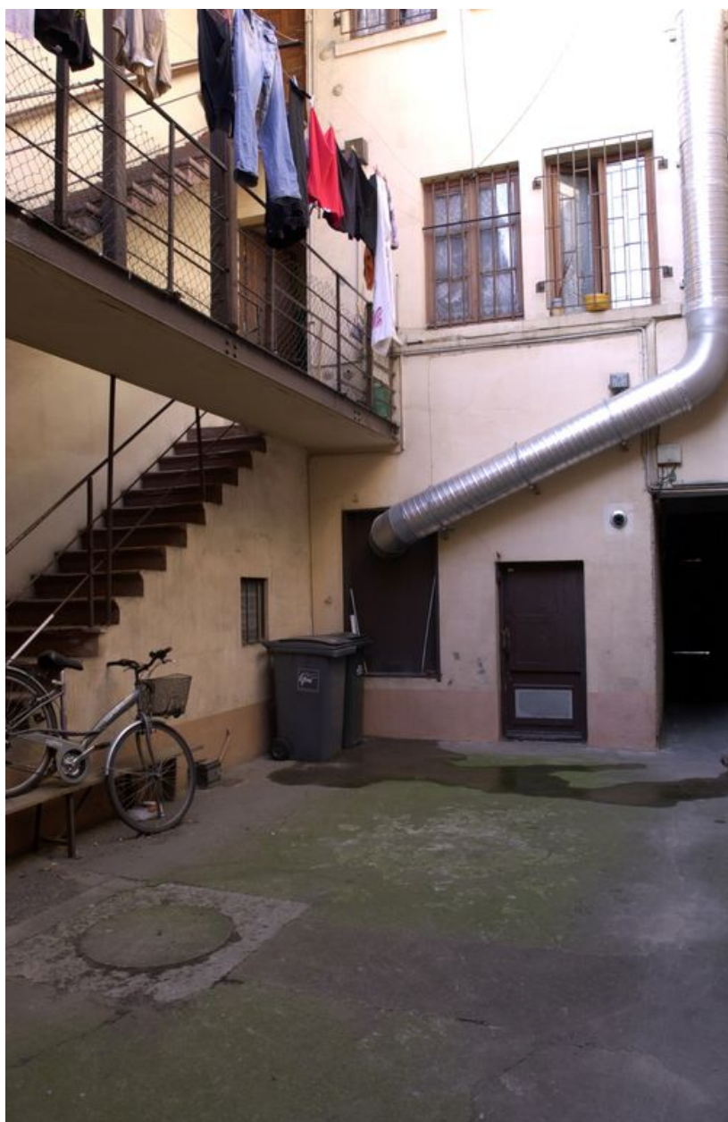
Vue de l'escalier et de la coursière reliant les deux corps de bâtiment
