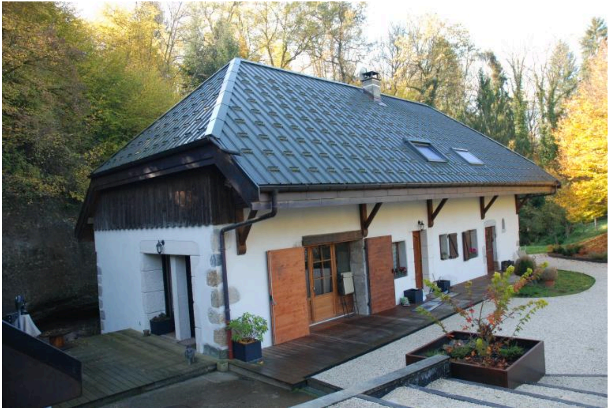
Vue d'ensemble de l'ancien moulin, face avant.
