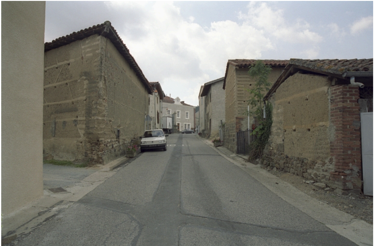
Vue d'ensemble de la rue principale du village en direction de Marcilly.
