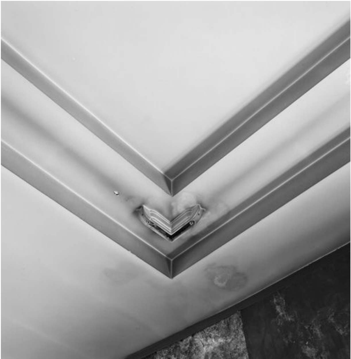
Le bâtiment-voyageurs : buffet, détail d'un motif d'angle du plafond
