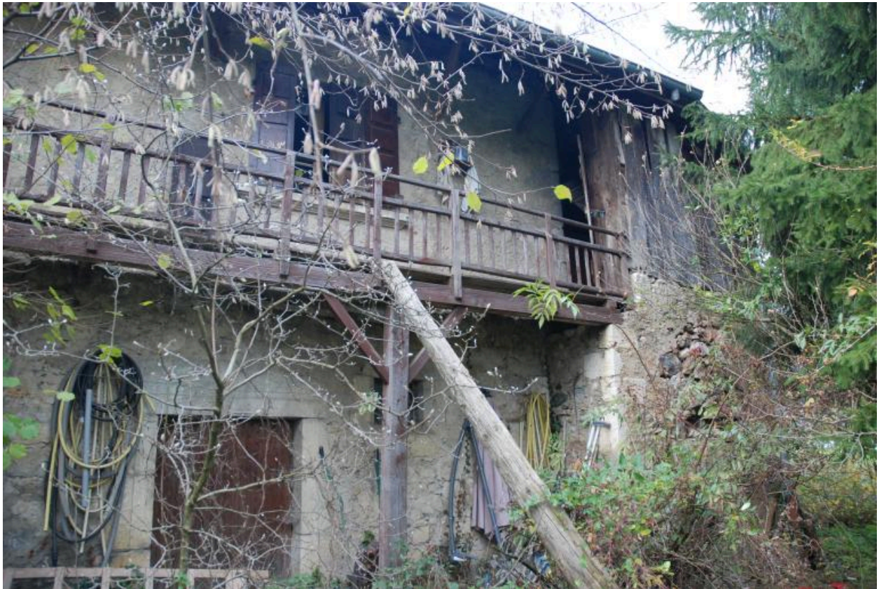
Maison, élévation sud (sud-est).
