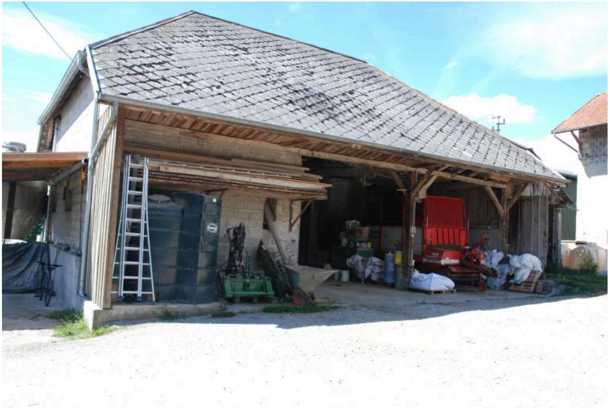
Vue de la grange-remise.
