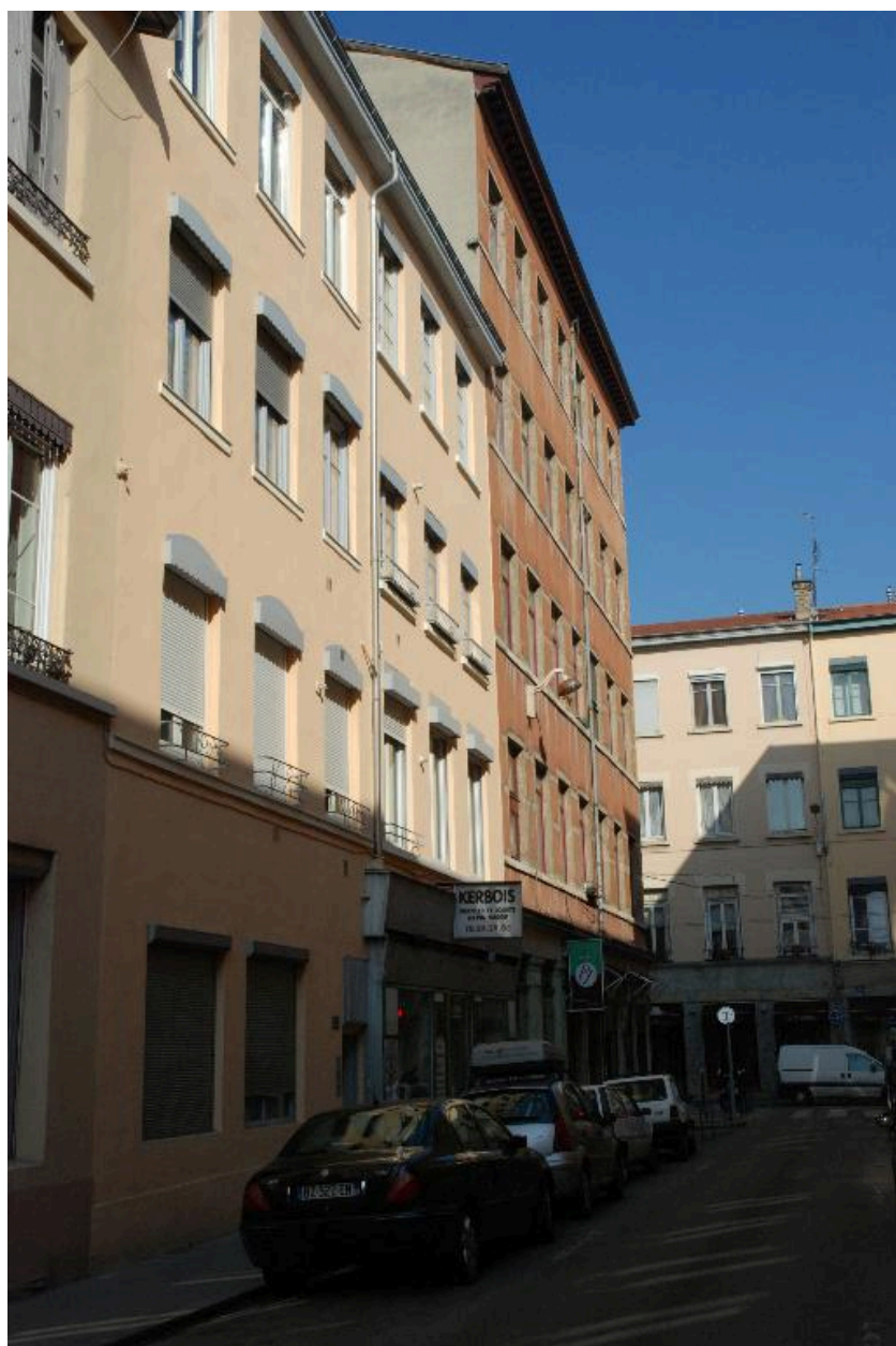
Vue d'ensemble sud est
