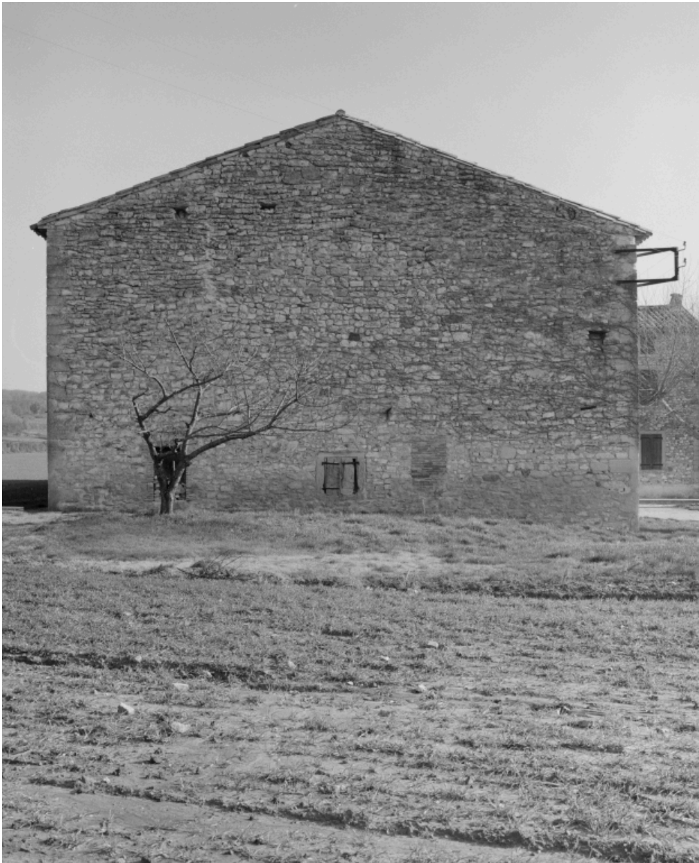
Mur pignon gauche : élévation latérale du logis du fermier.
