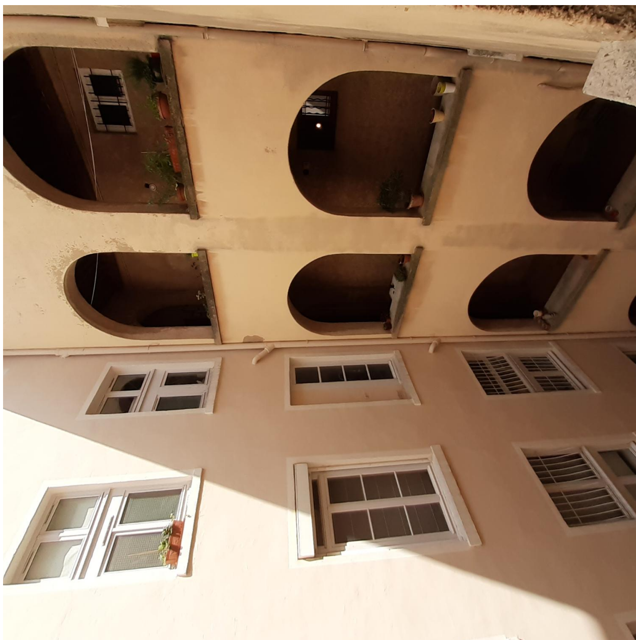
Détail façade sur cour
