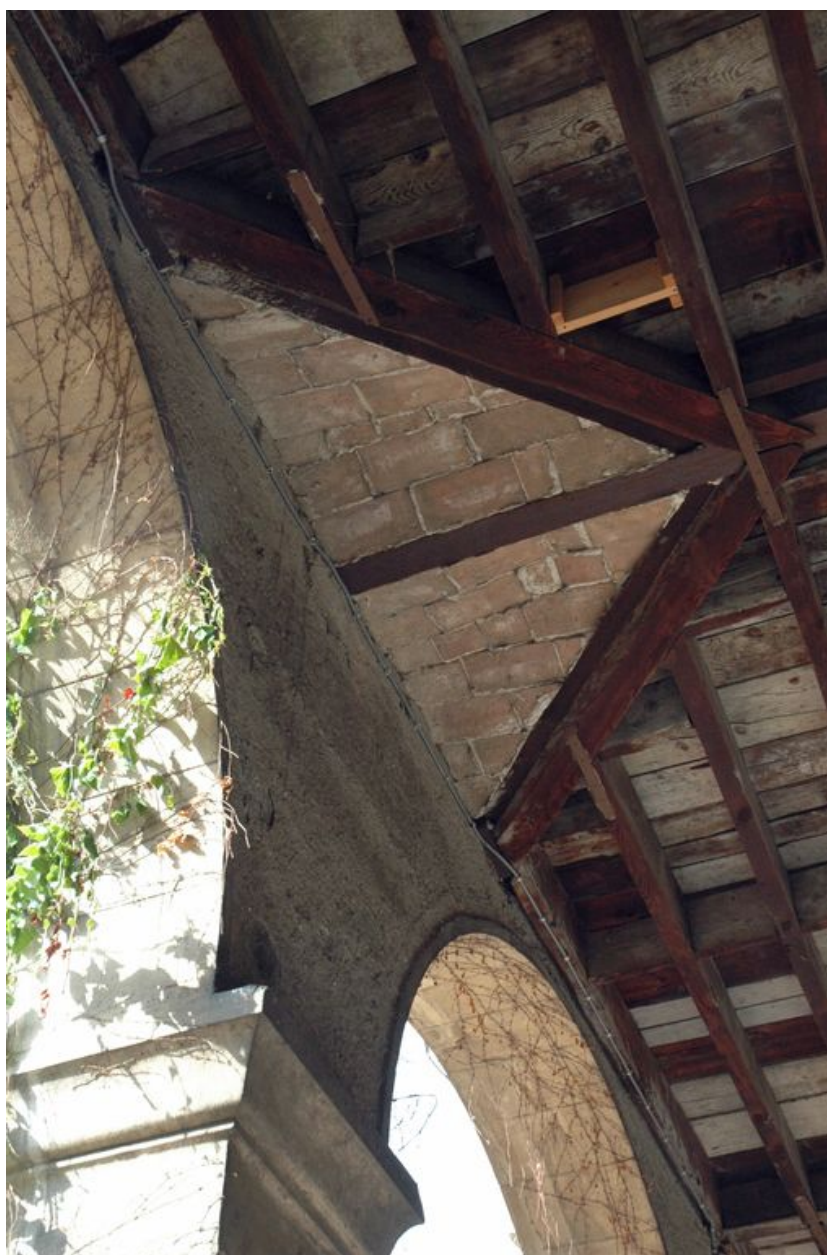
Bâtiment de la galerie, détail du plafond du portique
